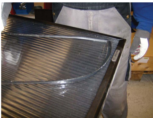
22. Colocar de nuevo la tira de goma entre la cubierta y el marco de aluminio. Empezar por la esquina.
